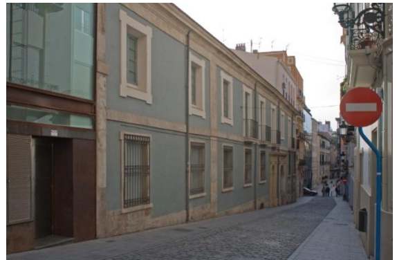
Fachada trasera. C/ Mayor, 40
